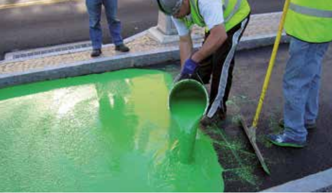
DEGAROUTE® bazlı yüzey işaretlemeleri tek katmanlı bir sistemde uygulanmıştır.
