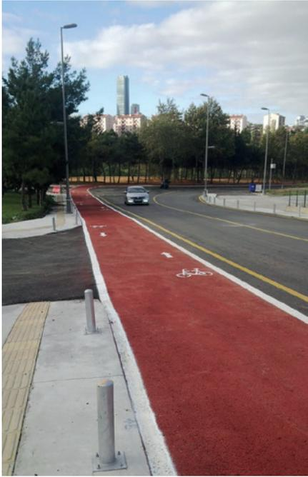
自2012年以来，高校越来越关注环境保护意识。这其中也包括修建一条贯穿整个校园的全新自行车道的“绿色校园”项目倡议。赢创赞助建设的自行车道路是基于DEGAROUTE®的双组分系统 – 首先是一层添加了防滑剂的基底涂层，然后是一层面层。这种首次在土耳其得到应用的特殊喷涂工艺，加工出了一种防滑的表面，能够提高自行车道的安全性。2600平方米的车道总计使用了四吨的材料 – 材料在混凝土和沥青上的附着能力特别好，因此，即使是薄薄的涂覆仍然特别经
