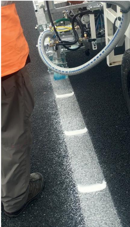
怀卡托高速公路项目是新西兰政府国家基础设施规划的一部分。这条双车道的公路将从孟买山(Bombay Hills)绵延至剑桥镇(Cambridge)以南。公路的几个路段已经建成，整条公路将于2019年完工。为了保障司机的行驶安全，公路的紧急车道将使用耐用的ATP冷塑型道路标线。这种道路标线由道路标线系统生产商——Ennis-Flint Traffic Safety Solutions 公司在DEGAROUTE®的基础上研制而成，并将借助Hofmann道路标线技术公司的设备涂刷到柏油公路上。
