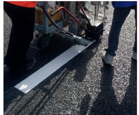
>>> 反射亮度达到280 MCD /平方米/流明，这比国家标准要求要高得多（新划白线 $\geq 150$  MCD /平方米/勒克斯，正常使用 $80 \geq$  MCD /平方米/流明）。白天高白度、夜晚高亮度的优势，对于驾驶员来说，在雾霾天、夜晚获得了标线的明确的指示，掌握了主动性，大大提高了行车安全。从长远来看，双组份冷塑性MMA材料具有道路标线材料中的最佳可视性，尤其是在潮湿、
