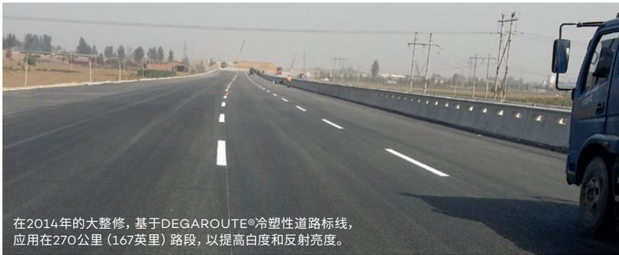
在2014年的大整修，基于DEGAROUTE®冷塑性道路标线，应用在270公里（167英里）路段，以提高白度和反射亮度。
