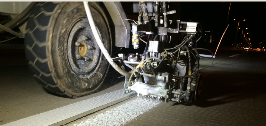
Распыляемые и структурированные прерывистые линии разметки на основе DEGAROUTE® наносились специализированным оборудованием на 3-километровый отрезок платной автострады штата Иллинойс.
