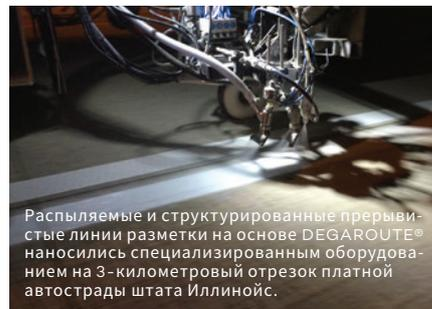
Распыляемые и структурированные прерывистые линии разметки на основе DEGAROUTE® наносились специализированным оборудованием на 3-километровый отрезок платной автострады штата Иллинойс.
