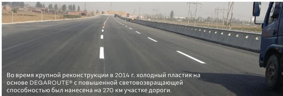
Во время крупной реконструкции в 2014 г. холодный пластик на основе DEGAROUTE® с повышенной световозвращающей способностью был нанесен на 270 км участке дороги.
