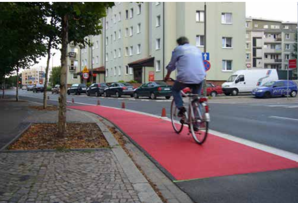
Segurança encontra design: Ciclovias coloridas com plásticos a frio DEGAROUTE®
