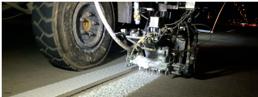
Utilizando equipamento especial, aplicaram-se sinalizações viárias seccionadas com spray e estrutura à base de DEGAROUTE®, num trecho de estrada de 3,62 km na Illinois Tollway.
