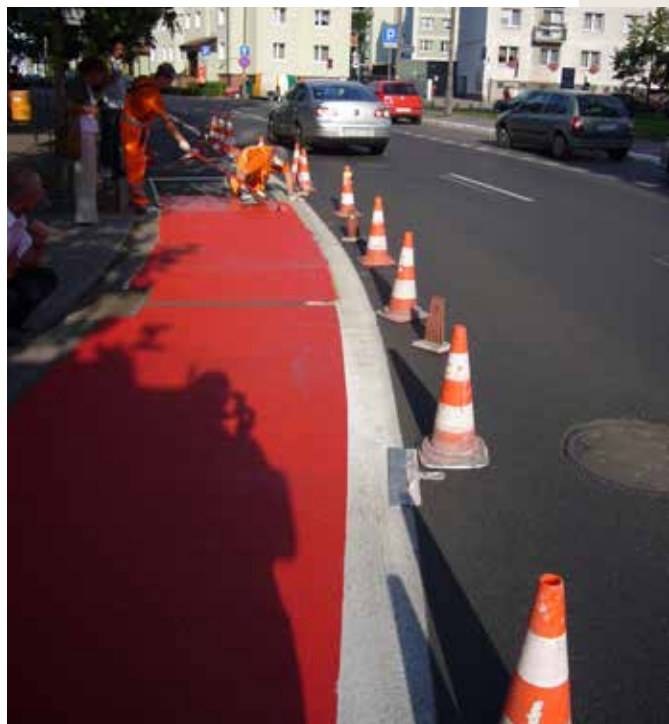
Zone durable de marquage avec une résistance antidérapante sur mesure basée sur le DEGAROUTE®
