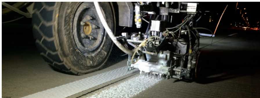
Las líneas discontinuas de un tramo de 2 millas de la autopista de Illinois se realizaron mediante marcado por aspersión y marcado en relieve del sistema DEGAROUTE® con maquinaria específica para ello.
