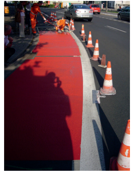
Señalización superficial de gran duración con propiedades antideslizantes a medida basada en DEGAROUTE®
