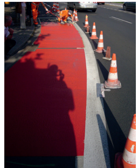
Langlebige Flächenmarkierung mit maßgeschneidert formulierten Anti-Rutsch-Eigenschaften auf Basis von DEGAROUTE®.
